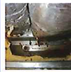
天井隠蔽部の見えない部分の腐食
